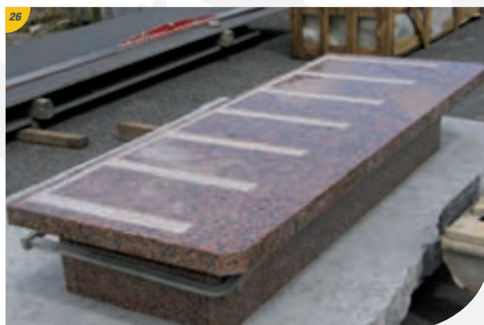
26 Mise en place du plateau sur la réhausse en le "clipsant" dessus.
