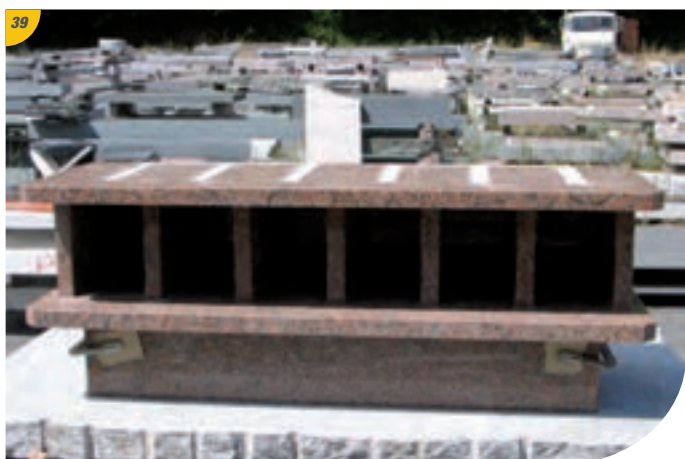
39 À cette étape, insérer les chevilles dans les trous.
