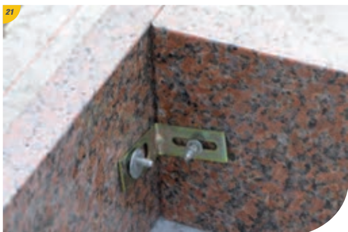
21 Visser à la clé de 13 en prenant garde que l'équerrage soit conservé.
