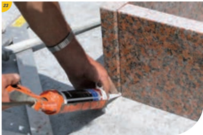
23 Joindre les parties externes de la rehausse. Tirez le joint après pulvérisation d'eau savonneuse (le dosage n'est pas important).
