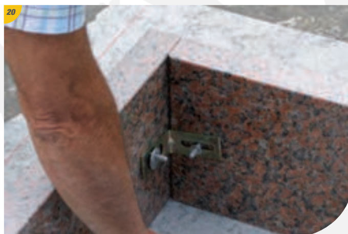
20 Mettre en place l'équerre et les rondelles.
