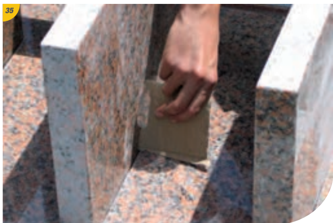
35 Finition des joints.
