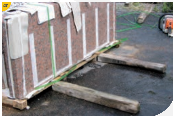
Avant de couper les cerclages, prévoir des cales en bois pour la mise à plat des plateaux.
