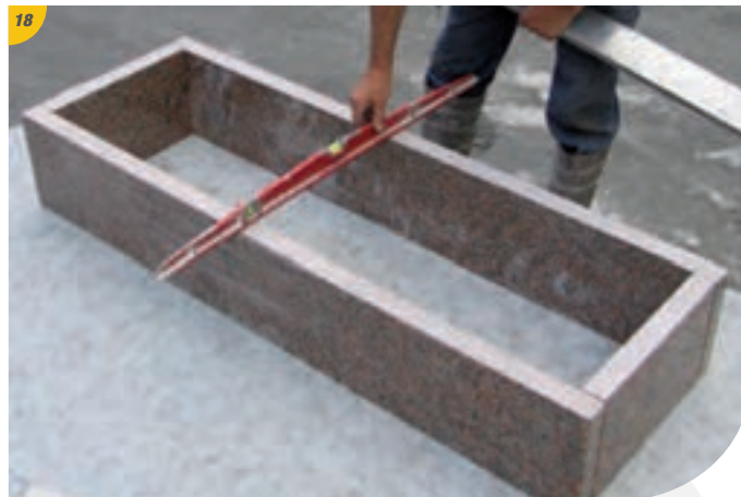
18 Contrôle des niveaux.
