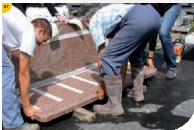
La manutention des plateaux les plus lourds se fait au minimum par 3 personnes, idéalement 4.
