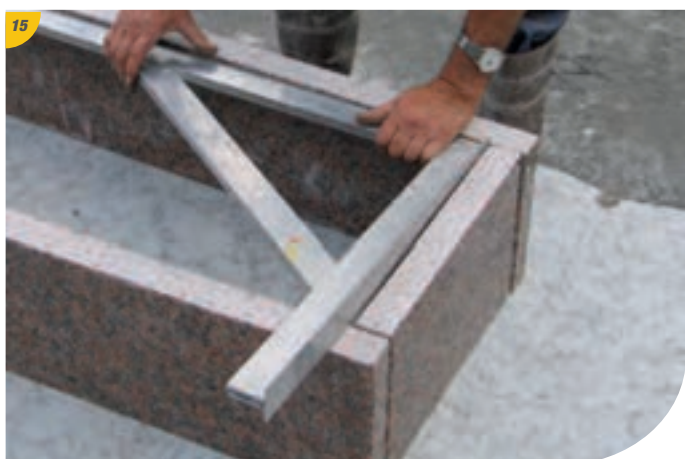
Assemblage et réglage à l'équerre.
