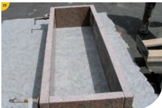
25 La réhausse est prête à accueillir le plateau.
