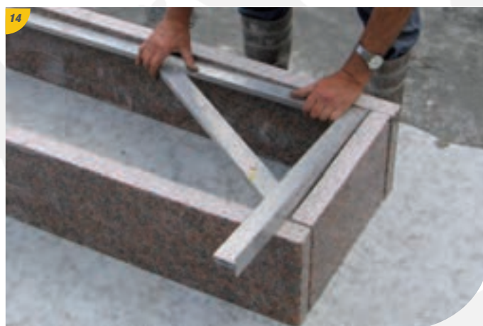
Assemblage et réglage à l'équerre.
