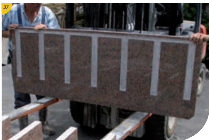
37 Mise en place du plateau supérieur (attention à l'ajustement des rainures dessus/dessous).
