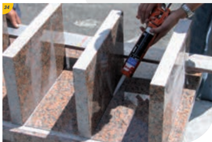
Appliquer les joints dans chaque case.
