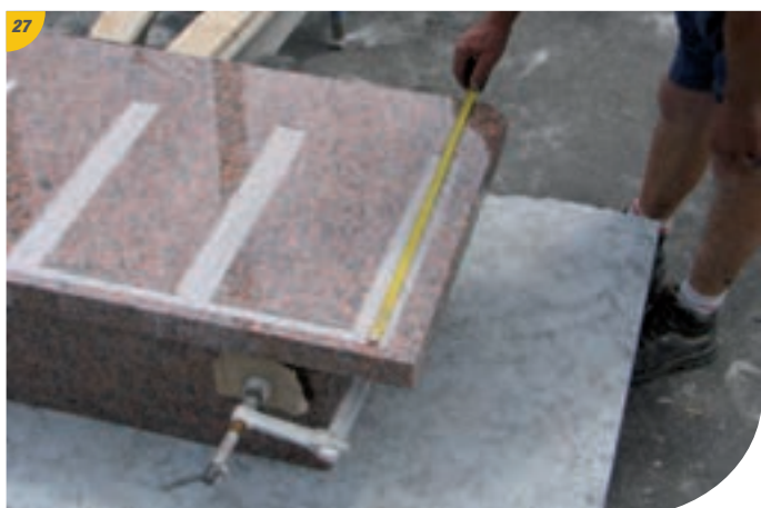
27 Prendre les mesures pour le repérage avant la mise en place des cloisons verticales.
