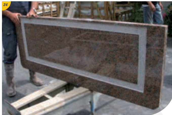
24 Quatre personnes sont requises pour le déplacement du plateau qui sera fixé sur la réhausse.
