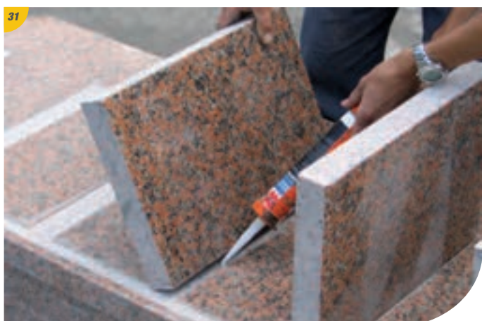
Coller les cloisons sur le plateau et les ajuster à l'aide d'un maillet. Encoller également les arrières bruts.
