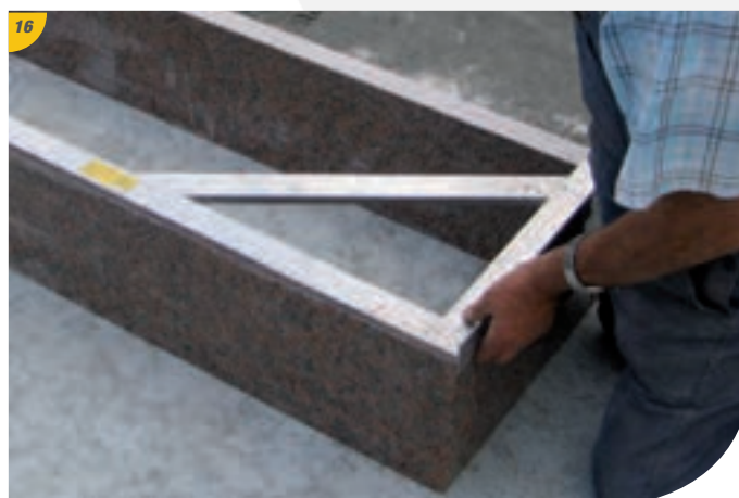
Assemblage et réglage à l'équerre.
