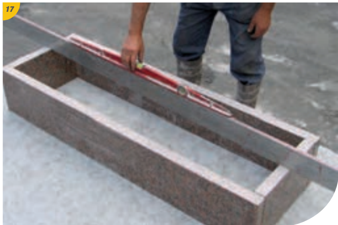
17 Contrôle des niveaux.
