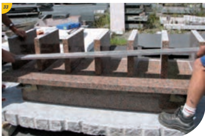
Contrôler à la règle l'alignement avant des cloisons (au maximum de l'avancée dans les rainures).
