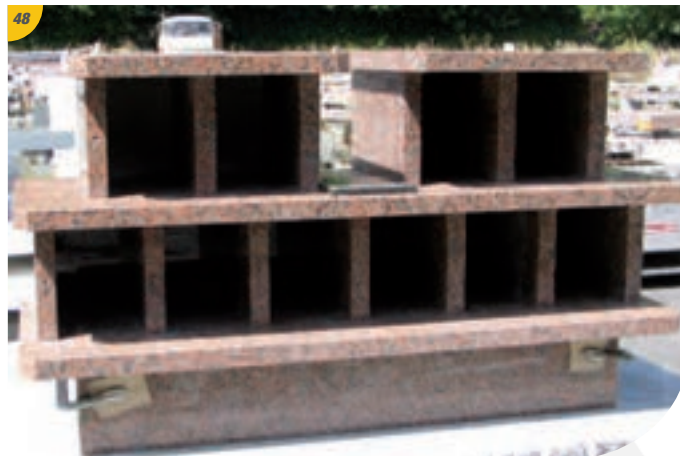
Il ne reste plus qu'un étage à monter.
