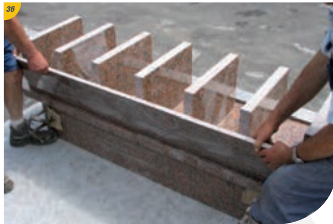
36 Mise en place du dos de fermeture, en ayant encollé toutes les cloisons verticales au préalable. Mettre les portes noires en place. Les portes percées s'utilisent pour les extérieurs. Visser les portes et fixer les rosaces sur les vis.
