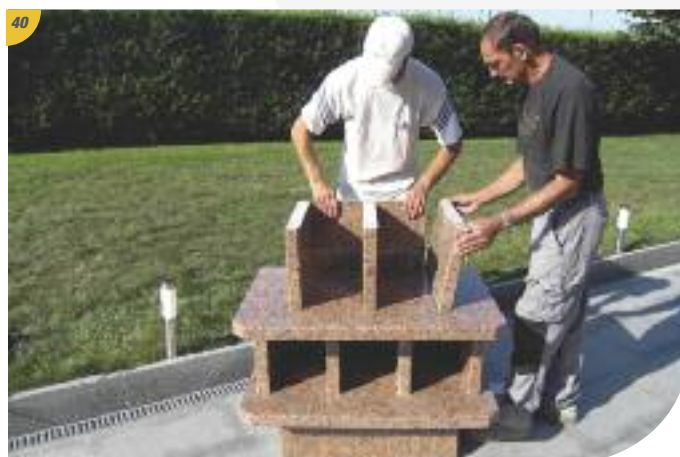
Prendre les mesures pour le repérage avant la mise en place des cloisons verticales.
